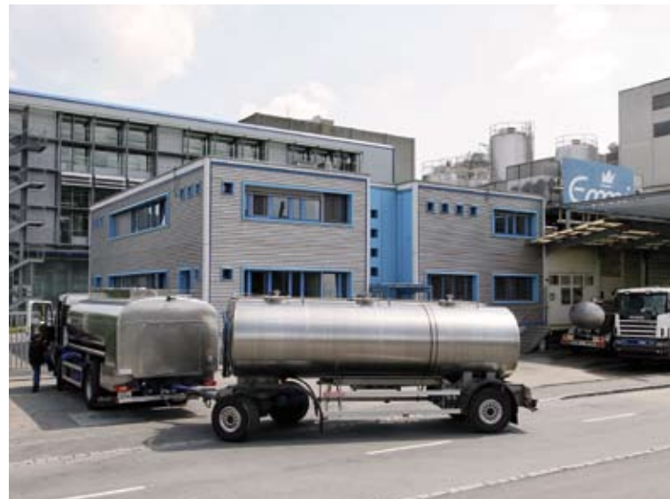
Bei der Milch- und Käseverarbeitung arbeiten Menschen oft alleine. Ob in den Trocknungstürmen der Molkerei, an der Filtrationsanlage oder im Labor: Personen-Notsignalsysteme garantieren Sicherheit.
